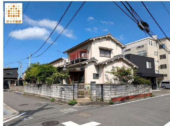
全体写真・南東側から撮影 (2024年9月)撮影
